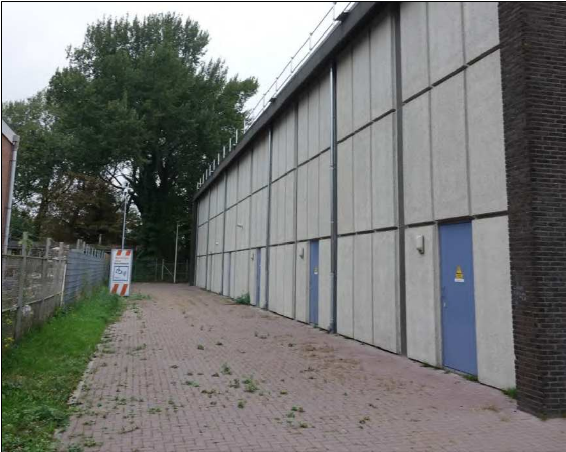
Figuur 2: Het oostelijke deel van het plangebied loopt langs het bestaande onderstation en is verhard.
