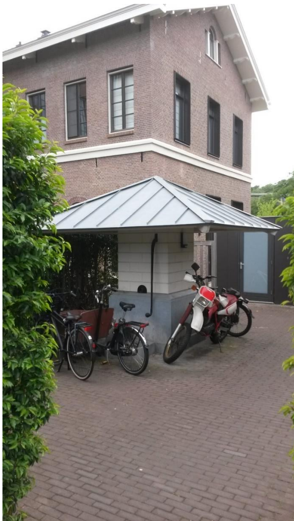
De waterpomp van de zuidwesthoek.
