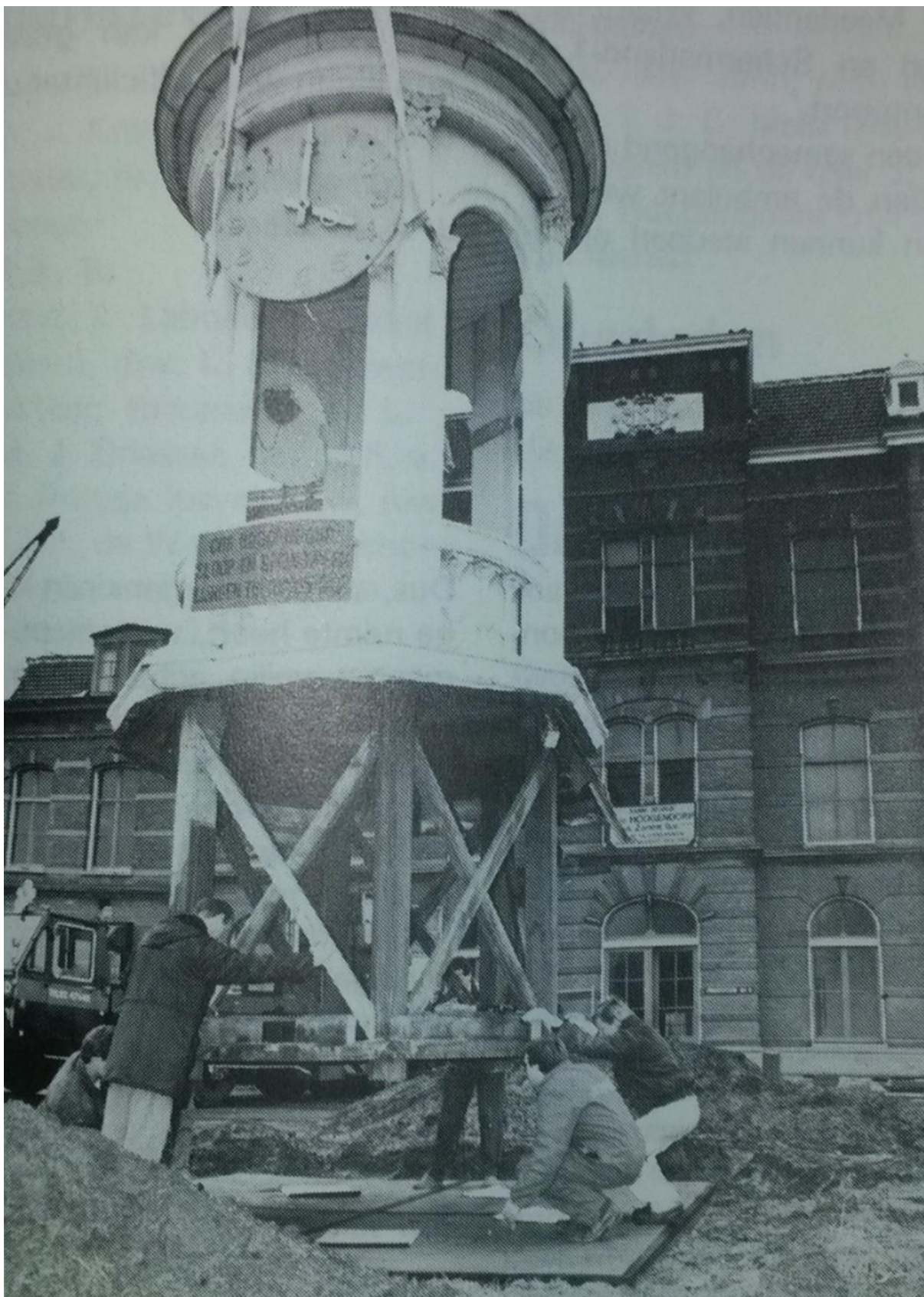
18 februari 1988 - Plaatsing van "het torentje" op de beoogde plek midden in het cirkelvormige plantsoen met een doorsnede van 15 meter recht voor de hoofdingang van het Nieuwe Gedeelte.
