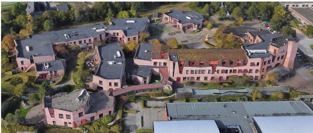
De jeugdkliniek „Amstelland” werd in het Oude Gedeelte van het Provinciaal Ziekenhuis Santpoort na een aanlooperperiode op 24 maart 1971 geopend en in 1997 ondergebracht in een nieuw gebouwencomplex aan de Kees Boekestraat 5 te Alkmaar. Amstelland-Tulpenburg fuseerde onder de druk van de landelijke overheid onder de naam Triversum (sinds 2022: GGZ Noord-Holland Noord jeugd & gezin).
