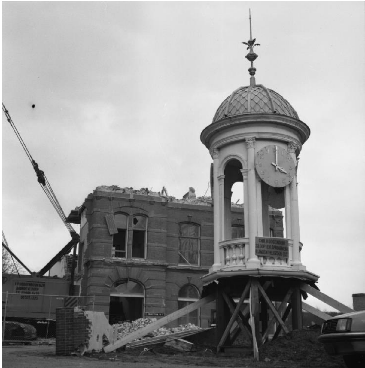
2 maart 1988 - De tweede verdieping en zolder zijn gesloopt. De gevelsteen werd blijkbaar tijdelijk elders opgeslagen totdat deze werd gepolychromeerd en in combinatie met de klokkentoren kon worden opgesteld. (foto: Pim Duurkoop)
