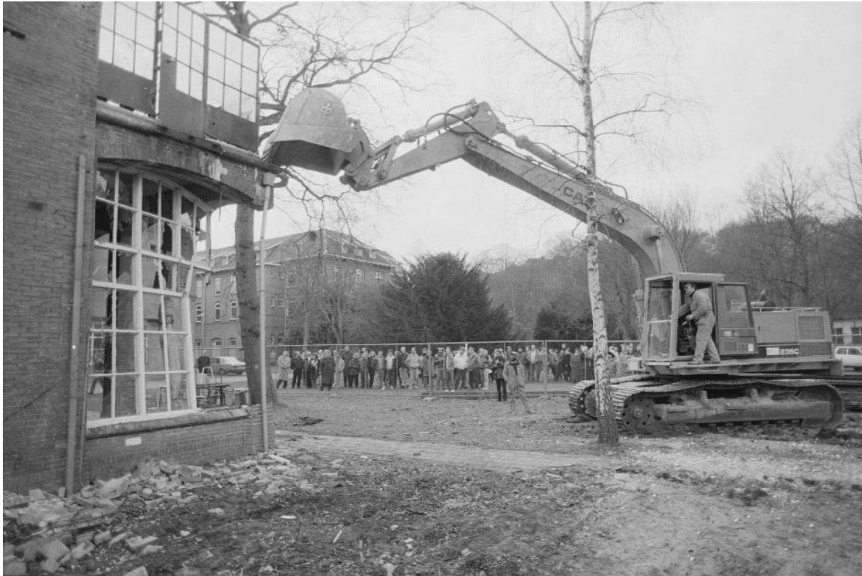
Situatie 13 december 1990. Sloop van de noordvleugel van het Oude Gedeelte, waarin de afdelingen Zaanland 3 en 4 waren gehuisvest. Op de achtergrond het later gesloopte Oude Zusterhuis uit 1898. Gebr. Bottelier B.V. Sloopwerken (NHA Fotopersbureau De Boer).
