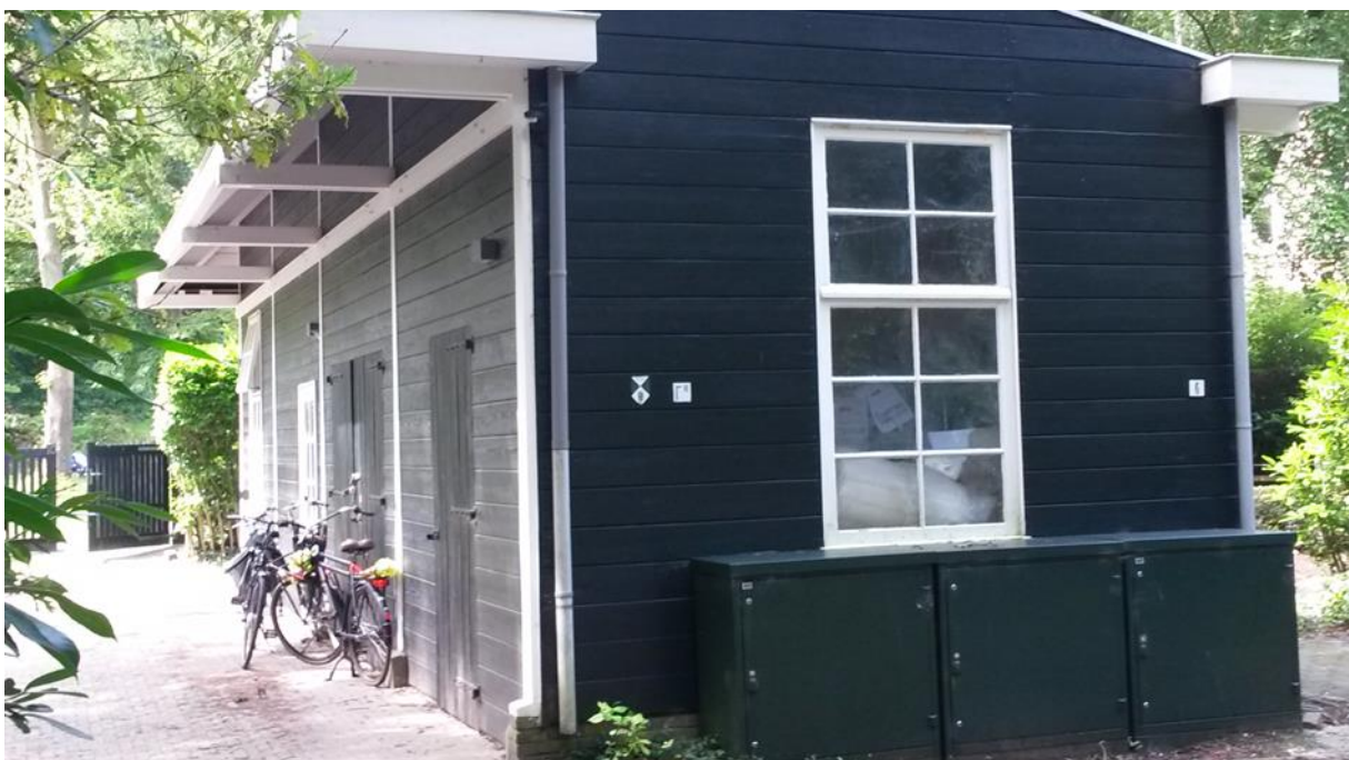
De enig overgebleven lighal van Zuid-Kennemerland destijds bestemd voor 10 volwassen TBC-lijdende. De oorspronkelijk open lighal is semi-recent geheel dicht gemaakt. Hoewel de lighal nog steeds uniek in zijn soort is, lijkt het nu meer op een schuur dan op een open lighal voor TBC-lijdende (2024).
