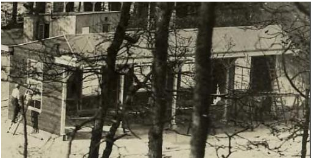
De open lighal voor maximaal 10 volwassenen ter bestrijding van tuberculose in aanbouw (1927).
