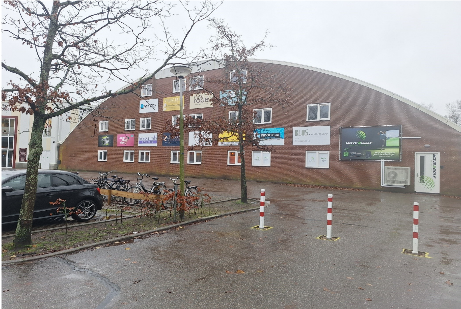
Links het geplaatste hek en daarachter de fietsenrekken.
