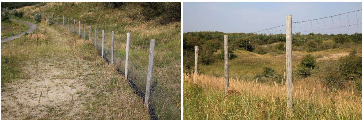
Figuur 4 Faunakerend raster in de vorm van een combinatieraster nabij Natuurbrug Zeepoort met (links) en zonder (rechts) amfibieschermen.
