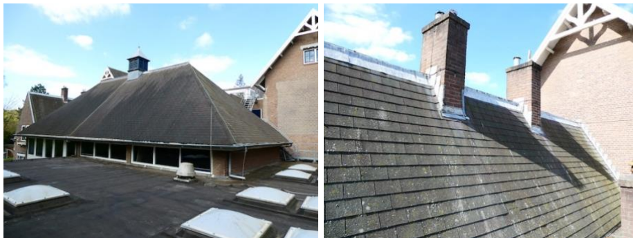
52. Dakbedekking gymnastieklokaal (links) en dakbedekking conciërgewoning (rechts)
