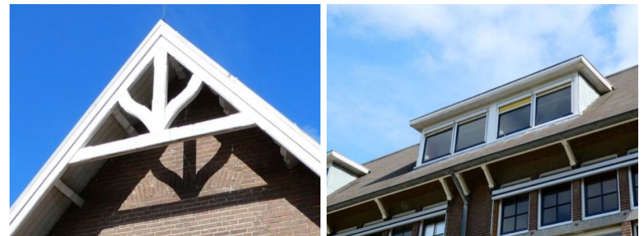
50. Sierlijke afwerking overstek kopgevel (links) en dubbele dakkapel buitenzijde rechter vleugel (rechts)
