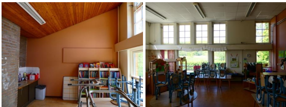
59. Schuin plafond leslokaal (links) en systeemplafond (rechts)
