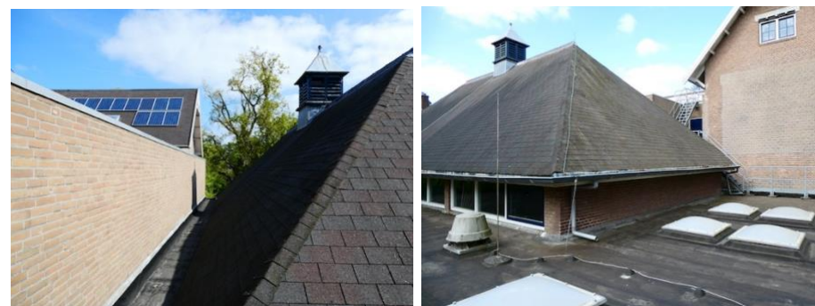
44. Gevel boven de voorgevel gymnastieklokaal (links) en linkerzijgevel (rechts)
