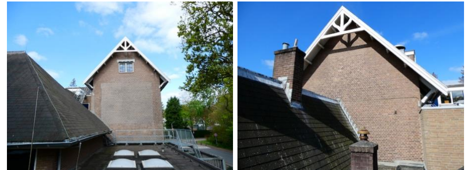
41. Achtergevel met kopgevel linker vleugel (links) en kopgevel rechter vleugel (rechts)
