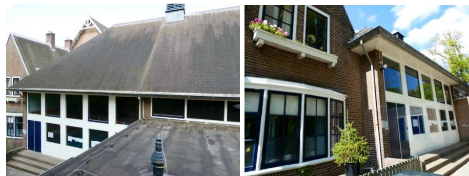
45. Achtergevel (links) en rechter zijgevel in aansluiting met de conciërgewoning
