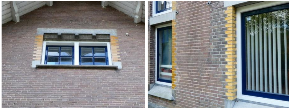
40. Origineel raamkozijn (links) dagkanten met geglazuurde en geschilderde hoekstenen (rechts)
