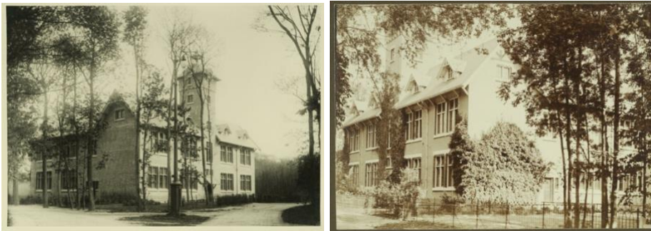
5. Voorgevel met toren en linker zijgevel (links) en rechterzijgevel (rechts)
