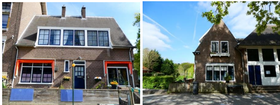
46. Voorgevel conciërgewoning (links) en rechter zijgevel (rechts)
