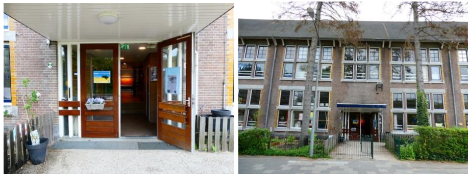
38. Hoofdingang (links) in het middelste travee met zichtbare bouwsporen in metselwerk (rechts)
