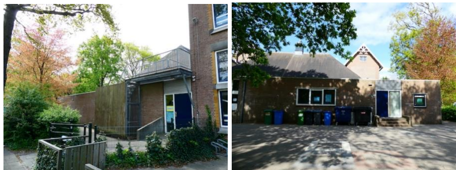
42. Linker zijgevel laagbouw (links) en achtergevel laagbouw (rechts)
