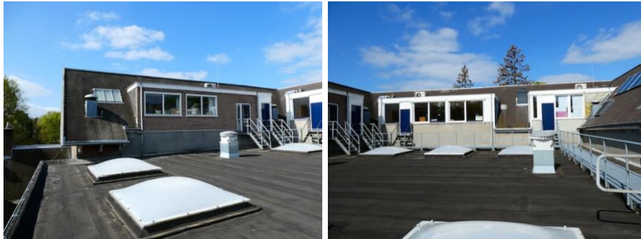
51. Dakhuis binnenzijde rechtvleugel (links) en dubbele dakkapel binnenzijde centrale vleugel (rechts)
