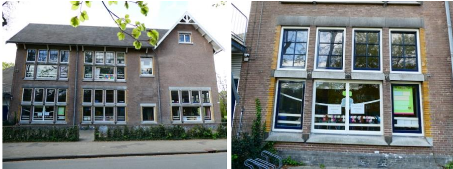
39. Linker zijgevel (links) en vensterinvulling beganegond linker vleugel met raamkozijn met middenstijl (rechts)
