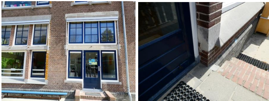
48. Gevelpui verbinding (links) en uitgezaagde borstwering rechter raampartij (rechts)
