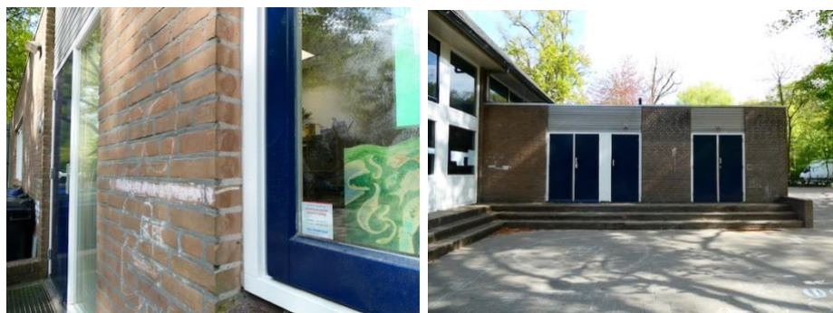
43. Links de originele gevelopening en rechts een ingezaagde opening (links) en de rechter zijgevel (rechts)
