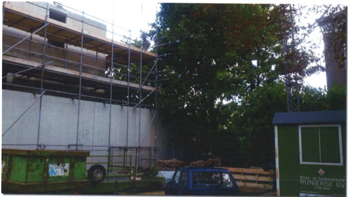
Afbeelding 11 De "Berlijnse muur" nog niet bekleed met steentjes en de hoekwoning van Bijduinhof nog zonder dak vlak naast Rijksmonument villa Tetterode rechts
