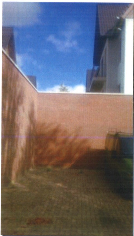
Afbeelding 12 Op de voorgrond het terrein van aannemer Rijnierse op het niveau van Vijverpark; op de achtergrond in de hoogte Bijduinhof, daartussen de "Berlijnse muur"
