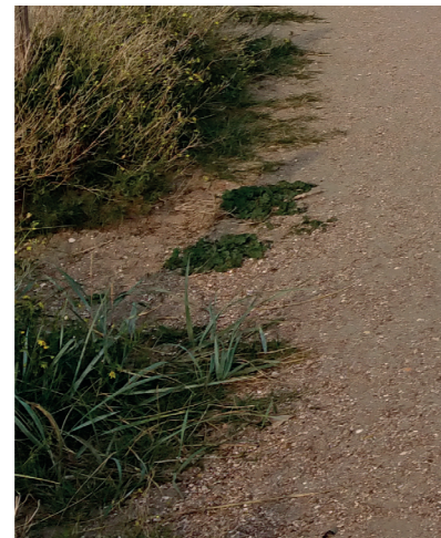
halfverharding met strandlook
