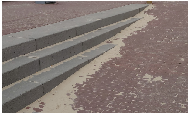
principeoplossing verdwijnende traptreden in glooiend maaiveld
