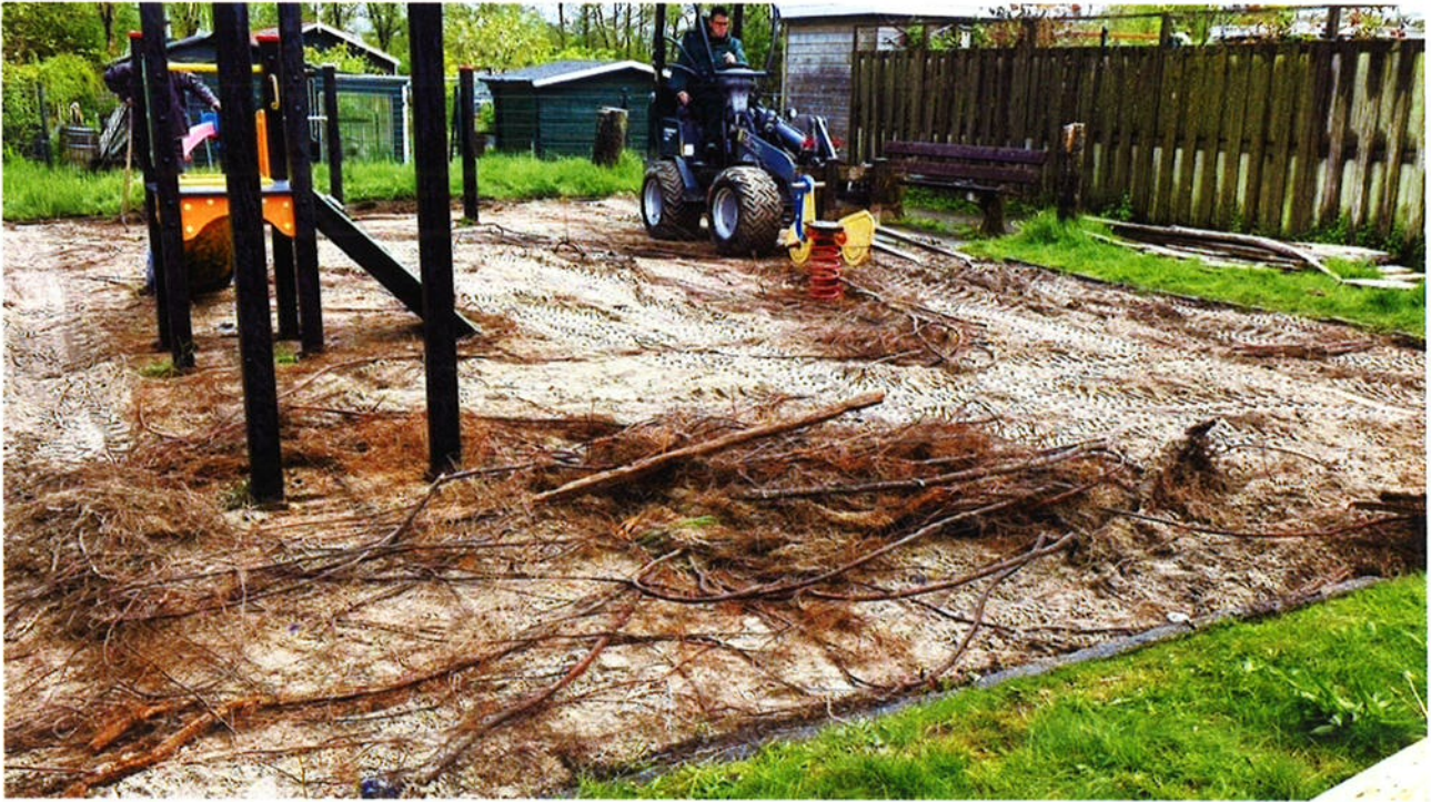
foto 3, opnamedatum 17 mei 2021 – situatie tijdens werkzaamheden
