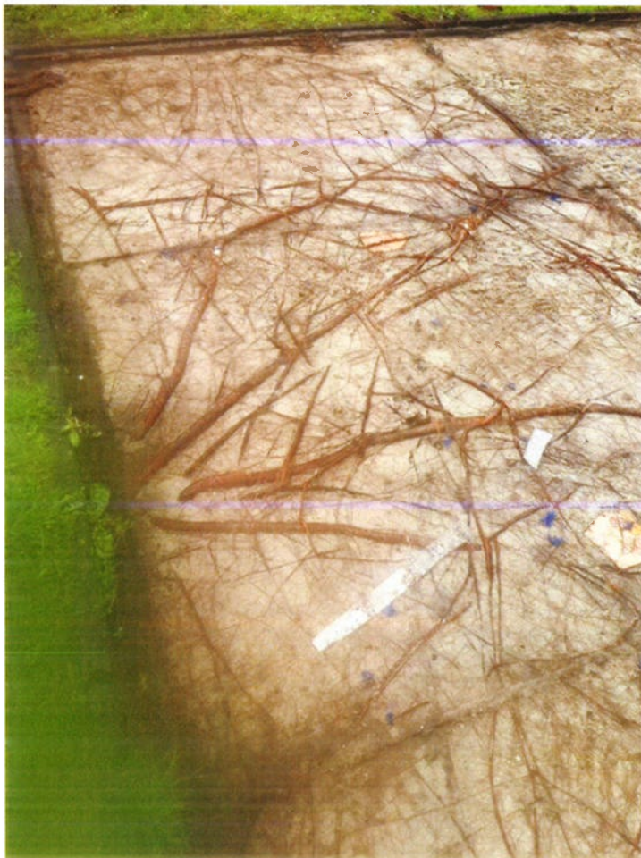
foto 4, opnamedatum 17 mei 2021 – situatie tijdens werkzaamheden
