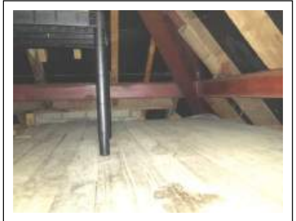
Foto 14: bergzolder met stalendraagconstructie en houten dakbeschot direct zichtbaar
