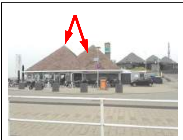
Foto 1: zuidgevel van Zeeweg 82 "t Eindpunt" met lei (bron 1) als dakbedekking
