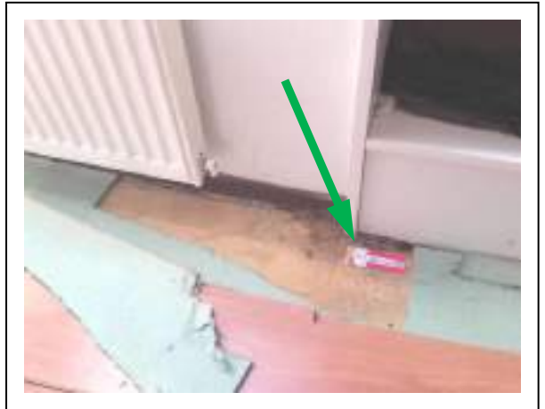
Foto 34: monsternamelocatie vloerbedekking/zeil (bron 7; M7) ter plaatse van kleine slaapkamer
