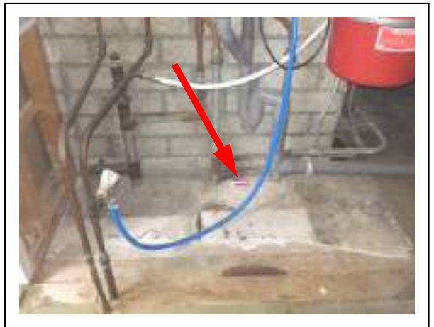
Foto 12: monsternameloctie plaat (bron 2; M2) op vloer in cv-ruimte
