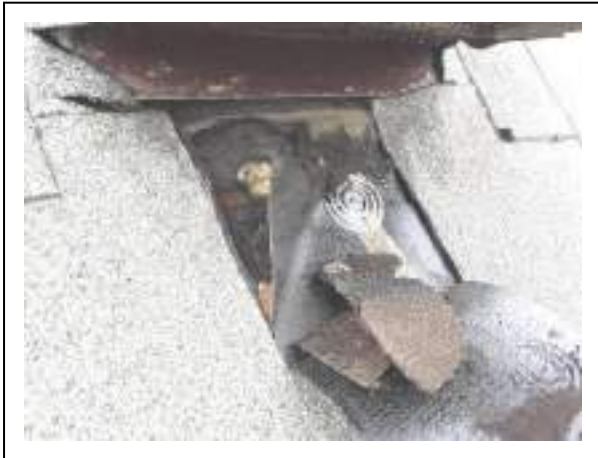
Foto 19: houten dakbeschot onder isolatie en bitumineuze dakbedekking
