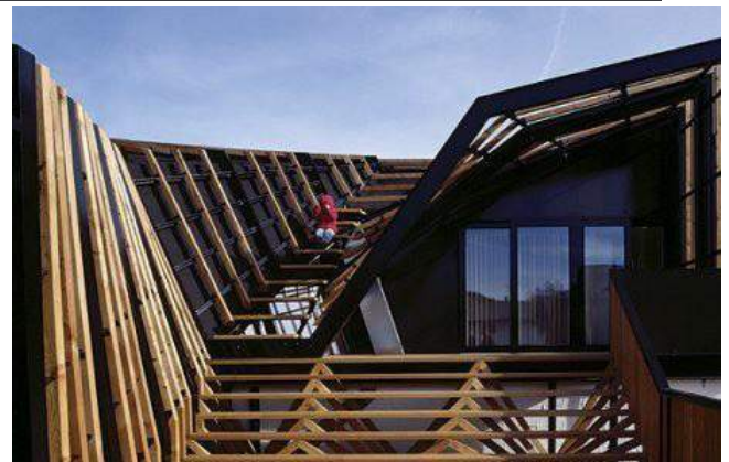
rastwerk maakt vorm en samengestelde kappen
