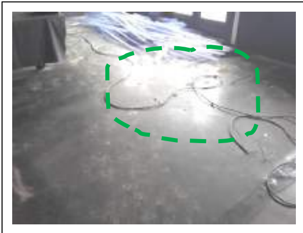
Foto 25: isolatiewol (bron 3) op vloer van keuken
