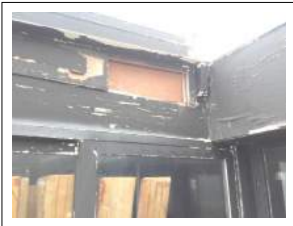
Foto 17: afwerkingen van hout aan gevel
