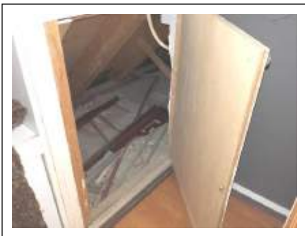
Foto 35: houten dakbeschoot direct zichtbaar achter knieschot
