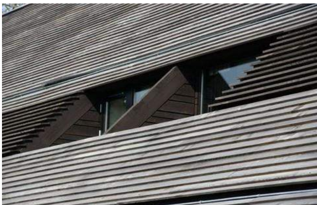
buitenruimte verwerkt in kapvorm (Arkitema architects)
