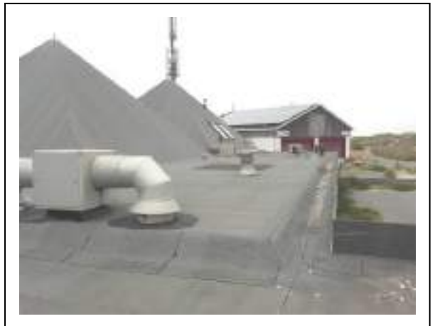
Foto 18: dak voorzien van bitumineuze dakbedekking met metalen luchtafvoeren
