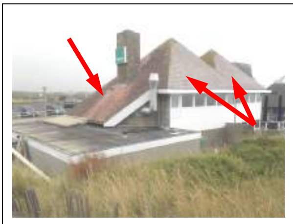
Foto 3: overzicht noordzijde met lei (bron 1) als dakbedekking
