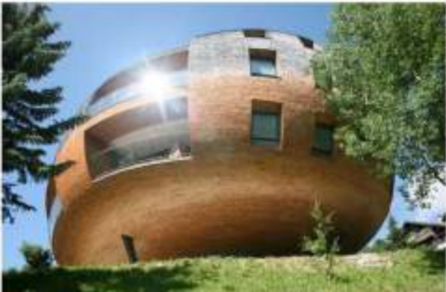
balkons inpandig voor een vloeiende vorm (Foster + Partners)
