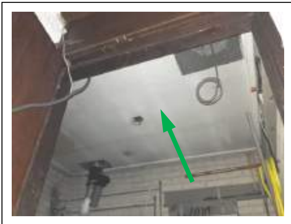
Foto 27: plafondplaat (bron 4) in cv-ruimte
