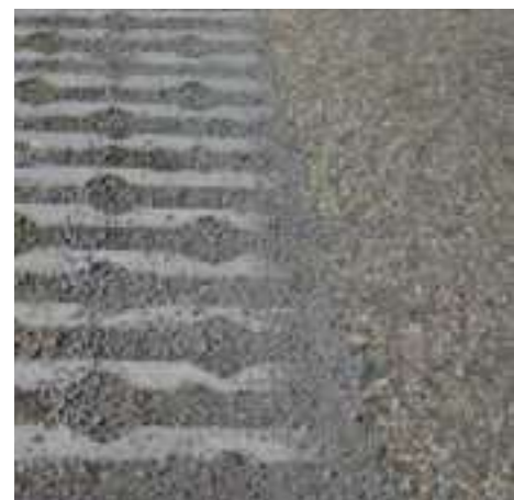
Duomix fundering onder grasbetonblokken
