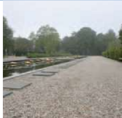
Duomix fundering onder granulaat paden
