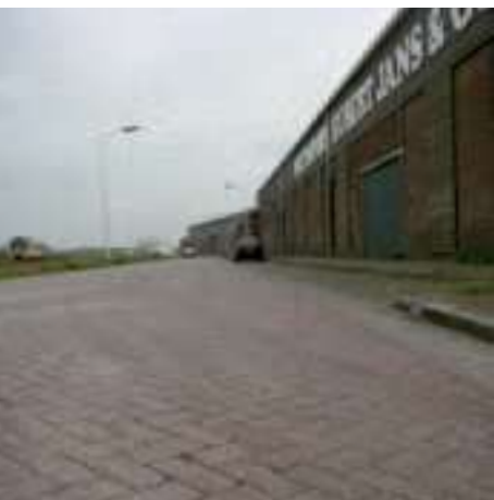
Duomix met elementverharding 6 jaar na aanleg
