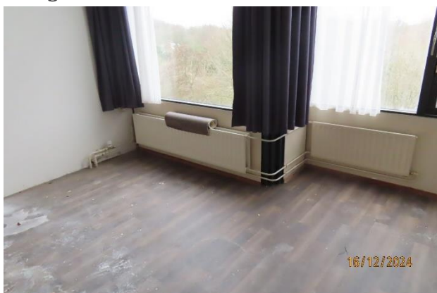
In aantal kamers borstwering bij beglazing erg laag
