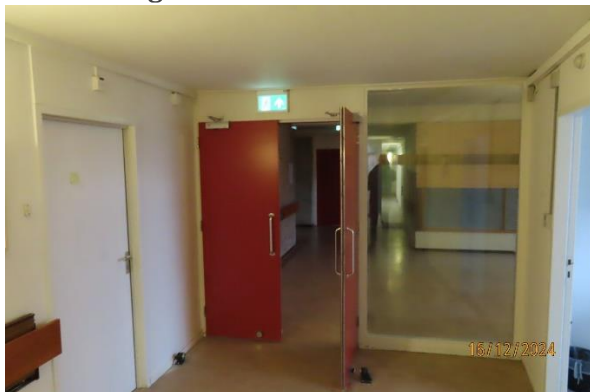
Draairichting van de deur in vluchtroute onjuist
