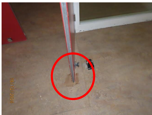
In brandscheiding wig onder deur geklemd
