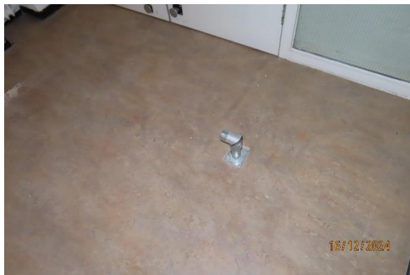
Kleefmagneten uit de gangen verwijderen
