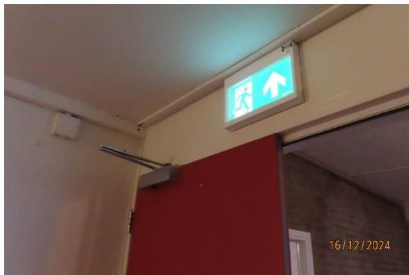
Draairichting van de deur in vluchtroute onjuist
