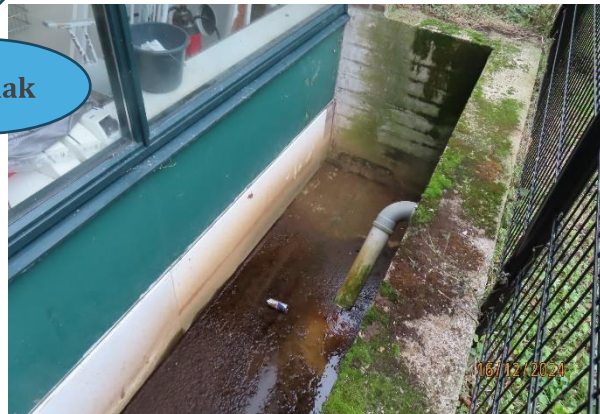
Situatie koekoek zonder water na het reinigen put
