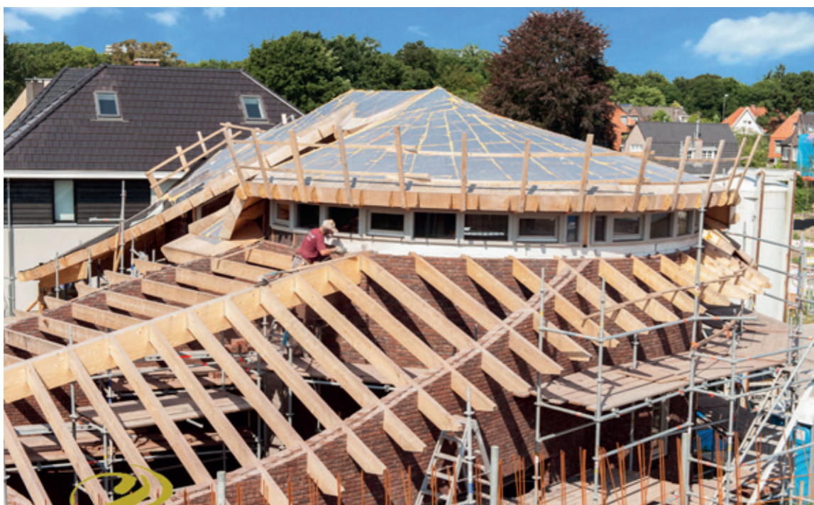
Woonhuis Philipsen in aanbouw
