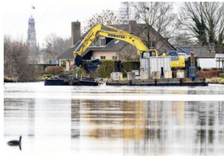
Een aannemer baggert in de IJssel. FOTO SANDER KONING/ANP/HOLLANDSE HOOGTE
