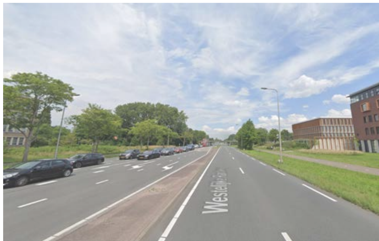
| Bestaande situatie Randweg
