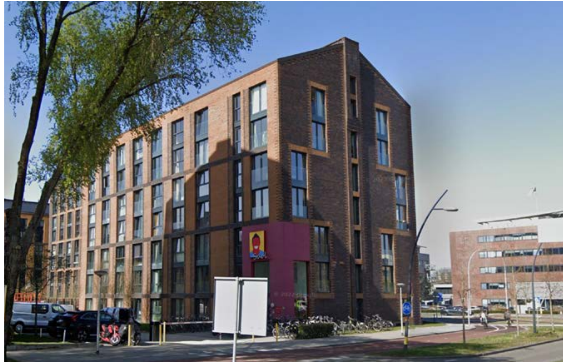
| Gebouw met een grotere korrelmaat en eenvoudige vorm
